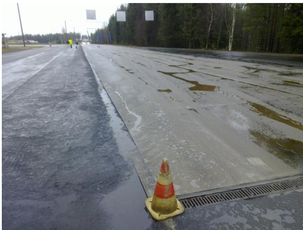
Kuva 4: Teräslevyalue ja sen pohjoispäässä oleva ritiläkaivo. Kuva otettu kohti etelää.
