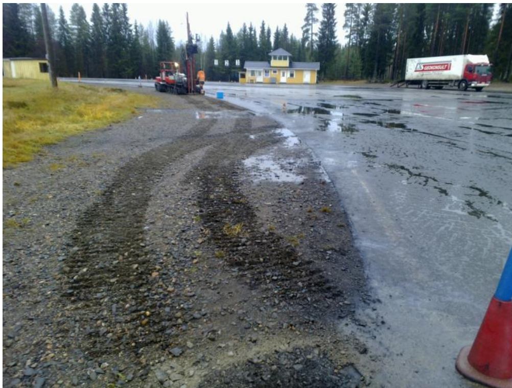
Kuva 1: Tutkittu alue kaarreradan reunalla. Tutkimuspisteen S3 kairaus käynnissä.
